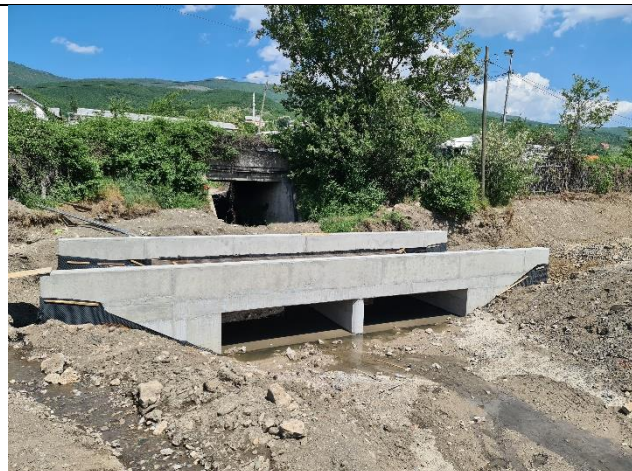
Ndërtimi i mbështetjes së përkohshme në Tunelin 7
