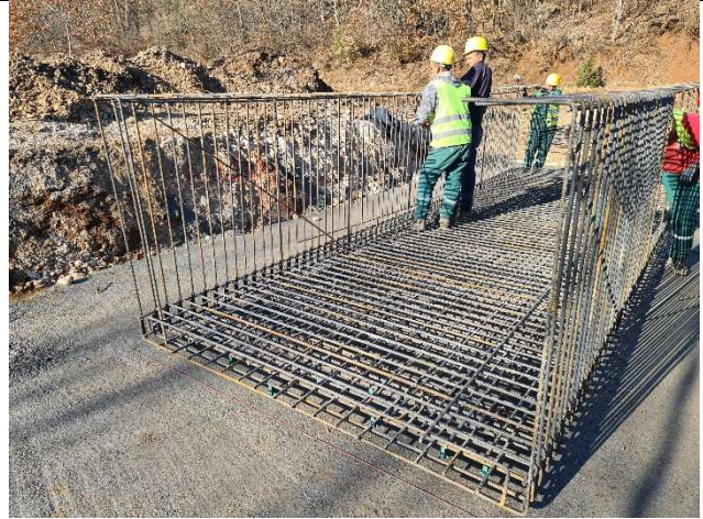
Instalimi i armaturës i Lëshesës
