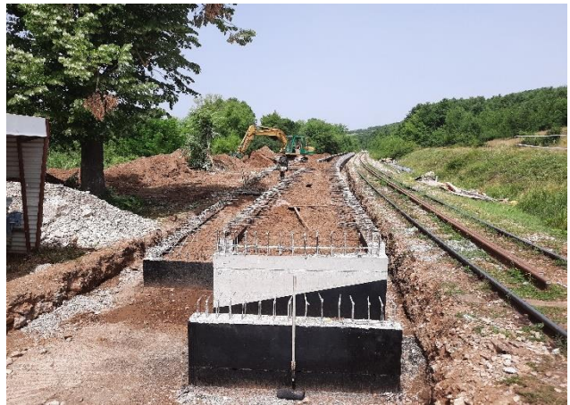
Vendosja e armaturës për pllakën e sipërme dhe rampat
