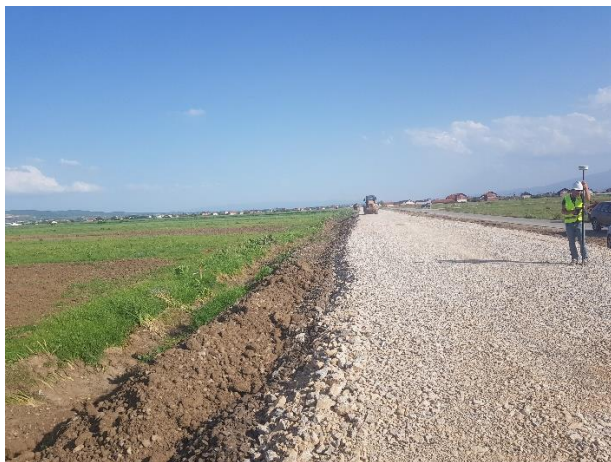
Kontrollimi i gjeometrisë për shtresën e bazës
