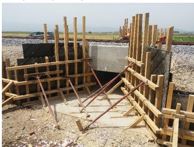
Ndërtimi i hyrje-daljeve për lëshesat C021, C022, C023, C024 and C025
