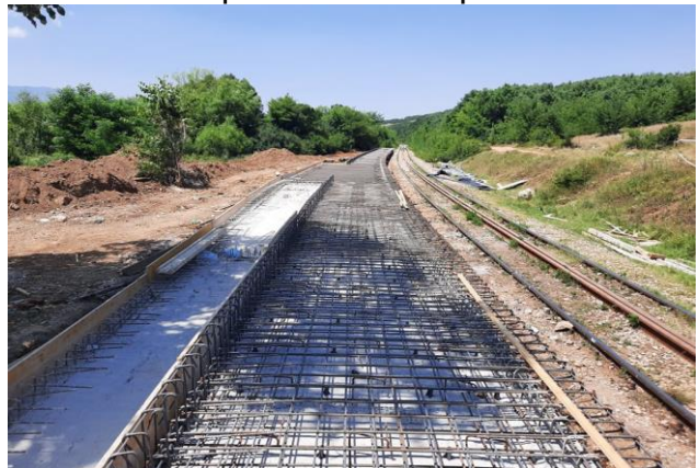
Vendosja e armaturës për pllakën e sipërme dhe rampat
