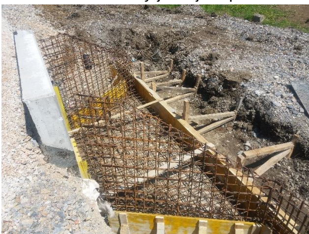
Ndërtimi i hyrje-daljeve për lëshesat C021, C022, C023, C024 and C025
