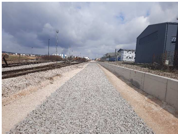
Punimet përgjatë linjës kryesore për pjesën Fushe Kosovë – Miradi, st.249+860 – 251+100 Vendosja e shtresës së parë të ballastit
