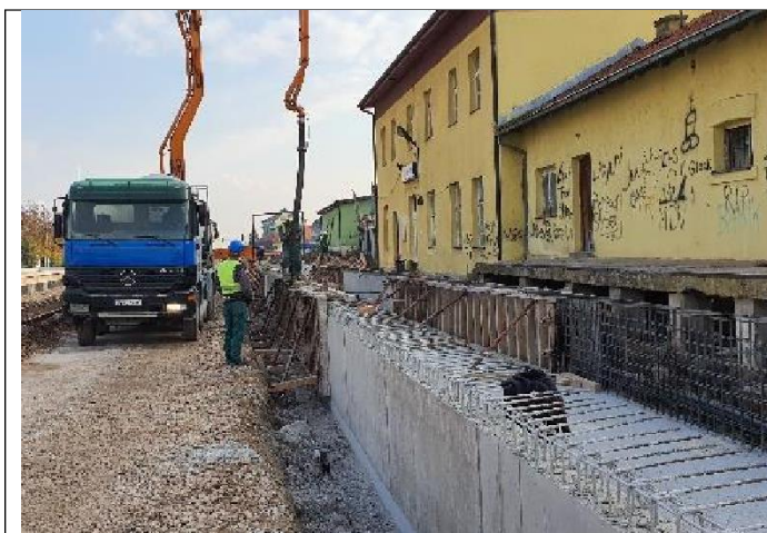
Betonimi i platformës së udhëtarëve në Lipjan
