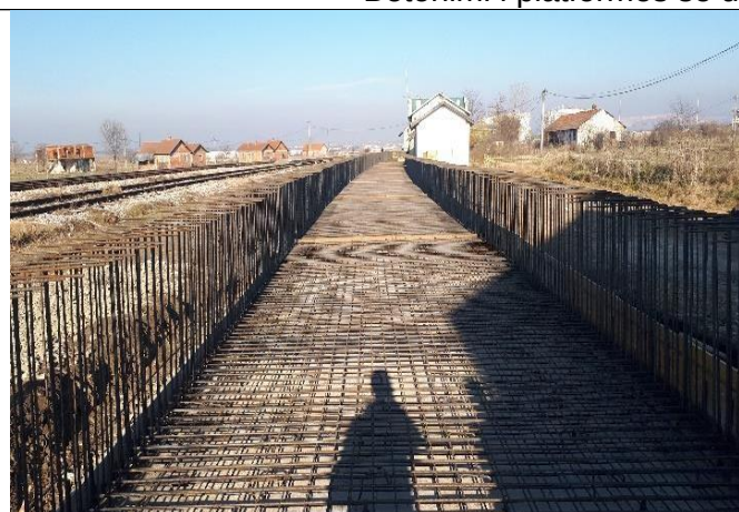
Betonimi i platformës së udhëtarëve në Bablak
