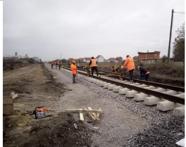
Lidhja dhe fiksimi i binarëve me traversa përmes lidhëseve
