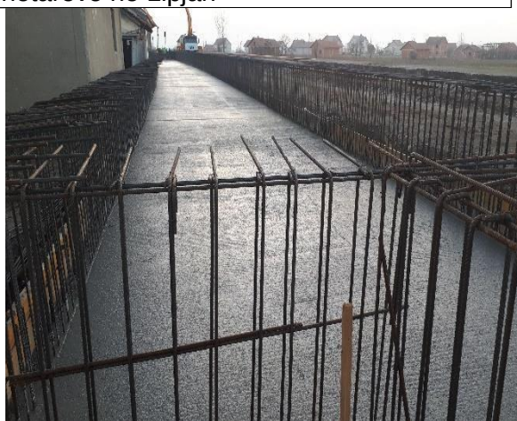
Betonimi i platformës së udhëtarëve në Bablak
