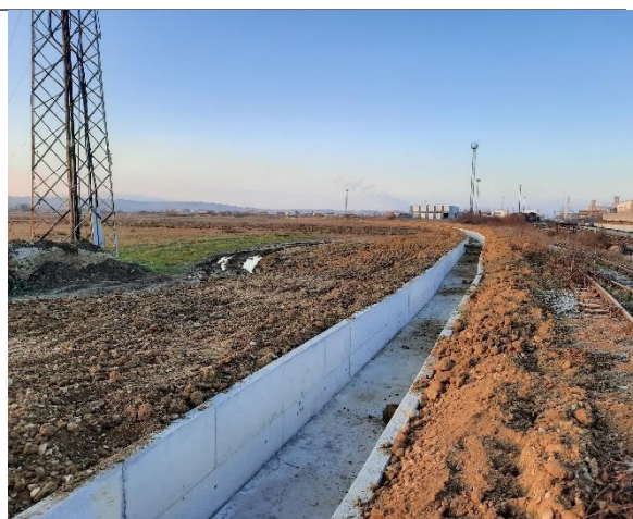
Ndërtimi i kanaleve ujëpërcjellëse
