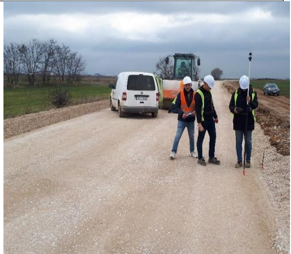
Testimet e shtresës së epërme të binarëve
