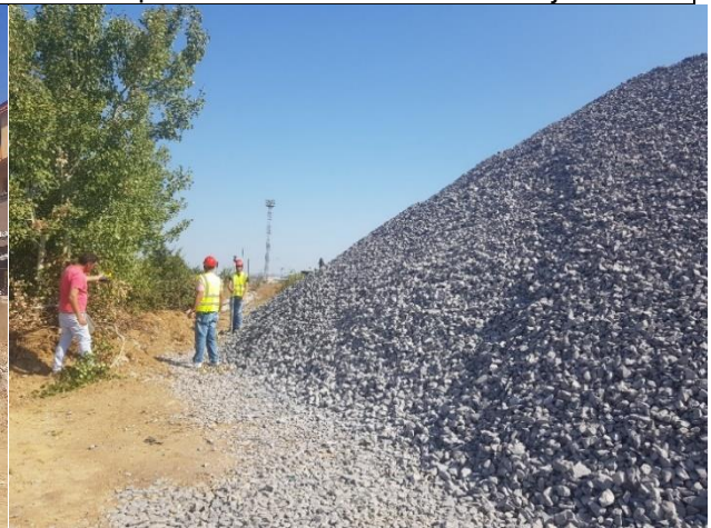
Matja e vëllimit të deponive të ballastit në Stacionin e Miradisë
