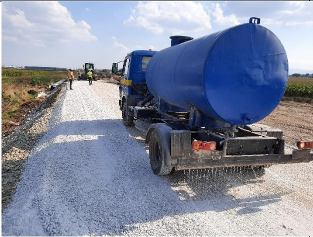
Përfundimi dhe testimi i shtresës mbrojtëse të binarit
