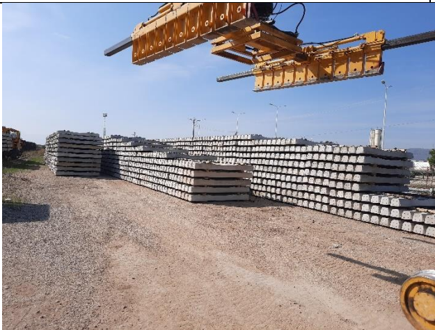
Deponimi i traversave në Stacionin e Miradisë
