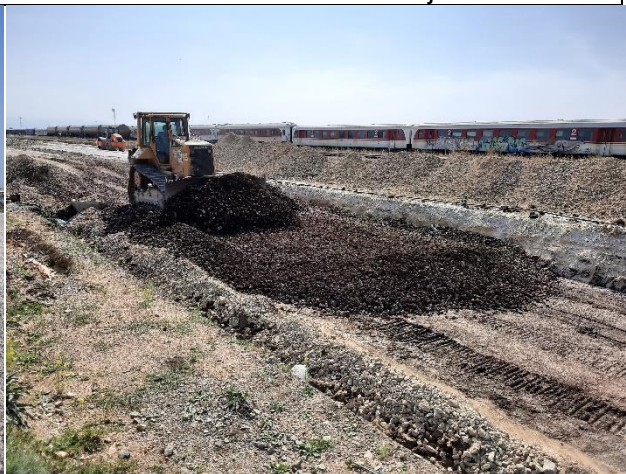
Shtresë e përmirësuar nga ballasti ekzistues CS. 208-214 në Miradi
