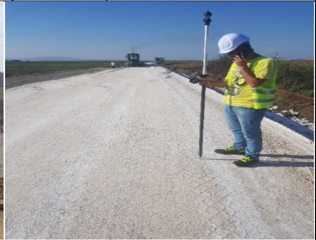
Kontrollimi i gjeometrisë në profilet 548 – 566 në Hashanaj
