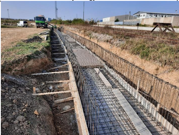
Armatura për pllaka dhe mure në stacionin hekurudhor të Miradisë
