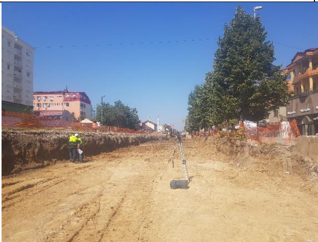
Kontrollimi i gjeometrisë për pjesën e gërmimit në Stacionin e Ferizajt
