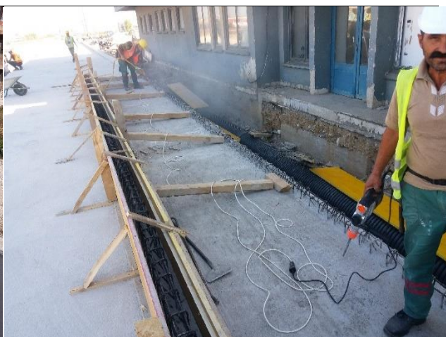
Ndërtimi i parapetit dhe rampave
