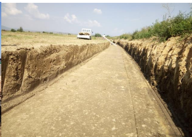
Gërmimi dhe ngjeshja e kanalit të djathë
