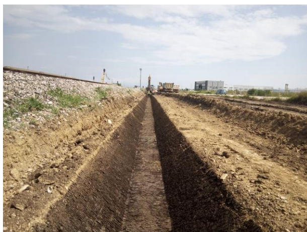
Kanali anësorë km. 250+940 – 250+300
