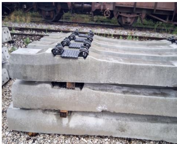
Montimi i pjesëve lidhëse në traversat e betonit nga GCF
